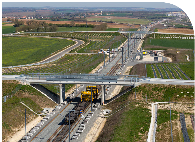
Chantier de la LGV Tours Bordeaux, photo aérienne de différents types de plantations de végétaux marqués Végétal local . Crédit : Bourdin sas
